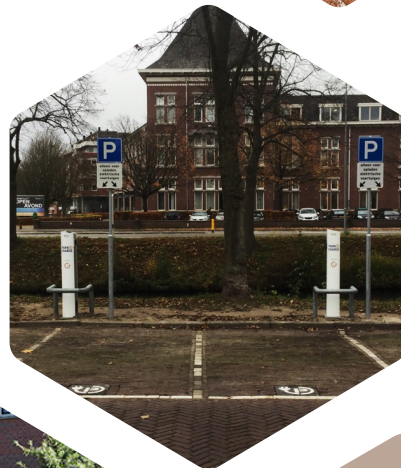
Figuur 4 - Systeem-straatkastopstelling in Arnhem
