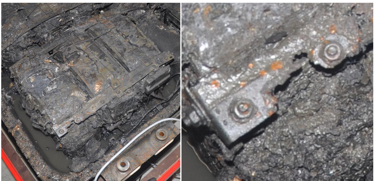
Afbeelding B4.20 Bovenzijde van de accueenheid met de beschadigde metalen rail
