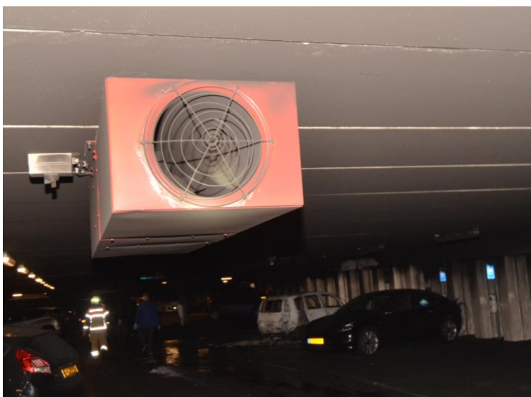
Afbeelding 4.4 Ventilatiesysteem in de Singelgarage
