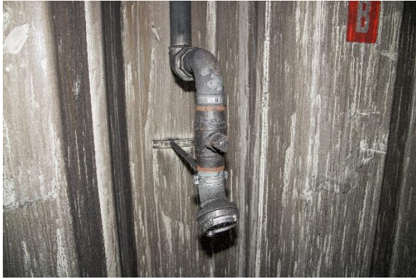
Afbeelding 2.6 Afnamepunt van de droge blusleiding
